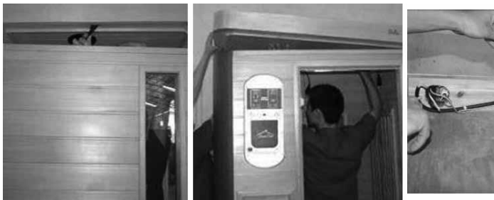
RYS 11 - Montaż panelu górnego
