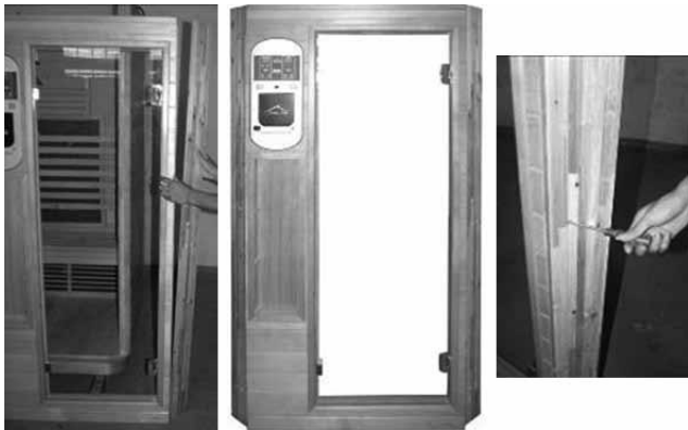
RYS 9 - Montaż listwy łączącej z panelem przednim
