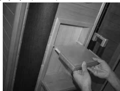
RYS 16 – Instalacja półki
