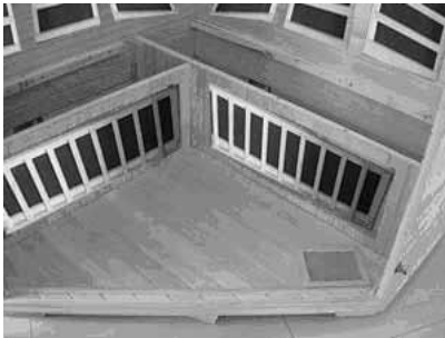
RYS 9 – Montaż krótkiej przegrody siedziska
