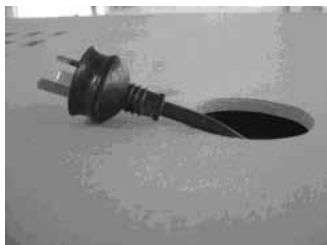
RYS-20 Przekładanie kabla zasilającego przez zewnętrzną płytę górną
