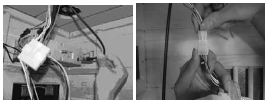
RYS-17 Podłączenie okablowania panelu sterującego
