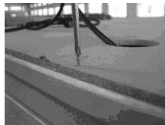
RYS-21 Mocowanie zewnętrznej płyty za pomocą wkrętów.
